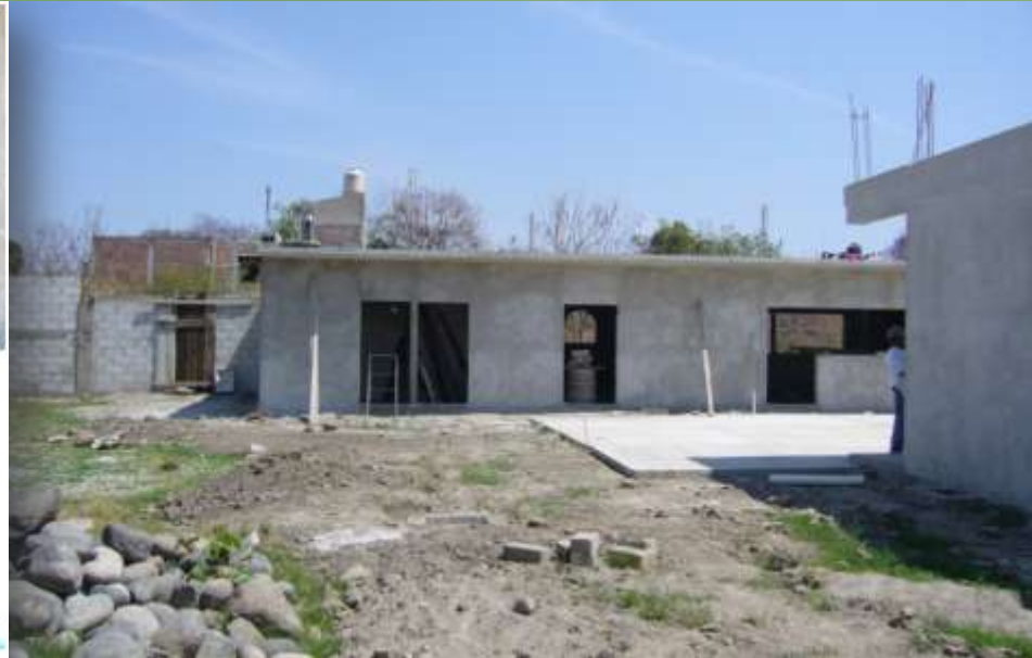
✓ Futuros baños, bodega y dirección
