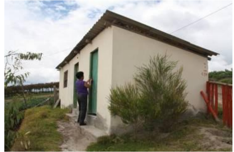
Detalle de la cocina comedor
